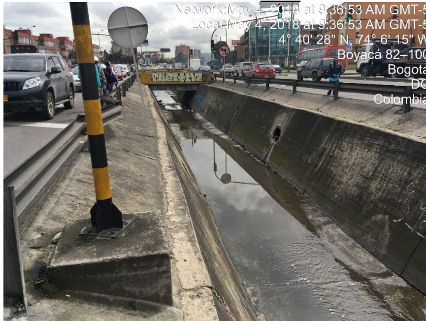
Fotografía 2. Punto de intervención del cauce del canal Boyacá mediante la construcción de un nuevo colector de 27" de diámetro en el costado oriental del canal Boyacá, denominado ENTREGA CANAL 8.
