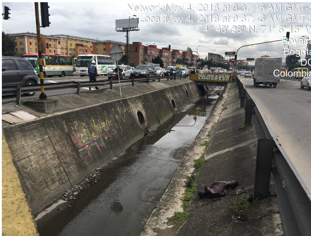
Fotografía 1. Punto de intervención en el cauce del canal Boyacá mediante la suspensión y clausura de tres (3) colectores en el costado occidental del canal Boyacá.
