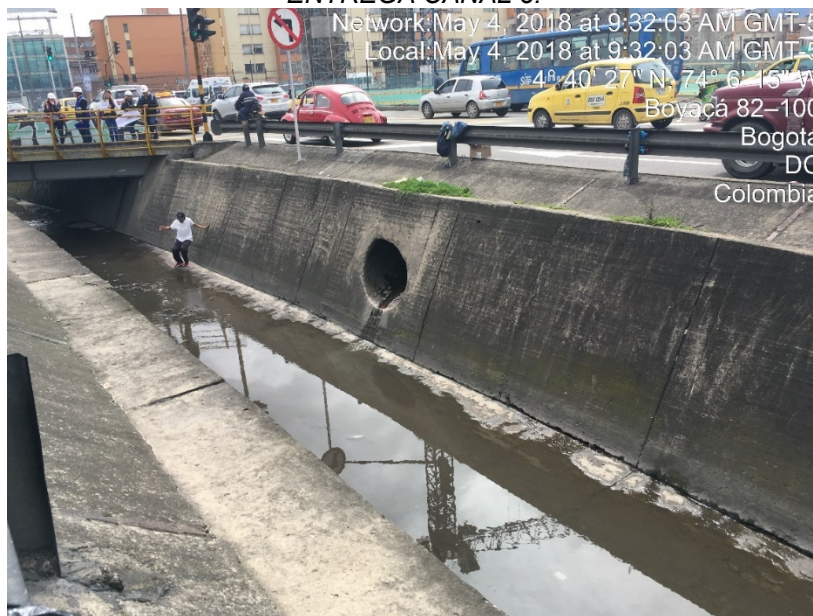
Fotografía 3. Punto de intervención del cauce del canal Boyacá mediante la optimización de un colector de 36" de diámetro a uno de 42", en el costado oriental del canal Boyacá, denominado ENTREGA CANAL.
